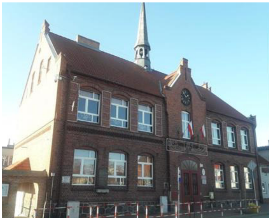
Budynek Szkoły Podstawowej
