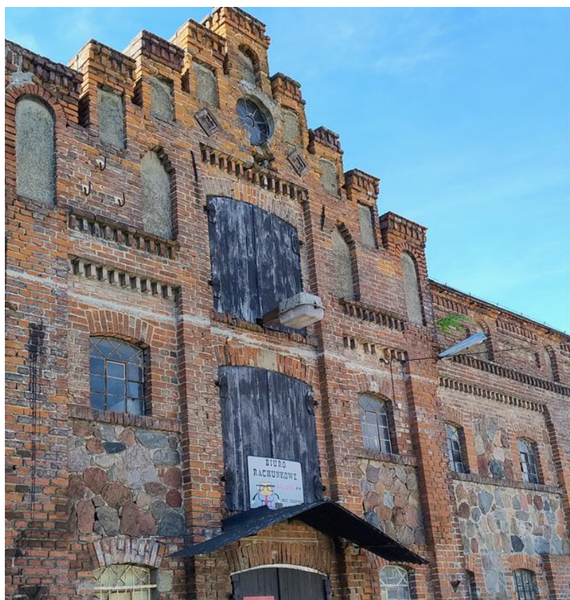
Budynek byłego magazynu zbożowego
